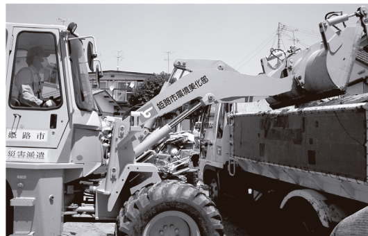
美化部職員によるがれきの撤去作業
